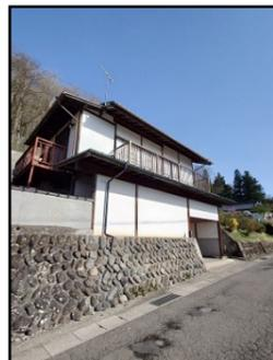
佐久市協和I様邸外壁補修工事も無事に終了しました。部分的に剥がれた白壁を一旦きれいに剥ぎ取り、下地の泥壁が崩れないように下地処理。その上から白壁を塗って完了と行った流れです。部分的に崩れていても、作業する単位はあくまでも面。木の柱や梁で囲まれた壁一面ずつで塗り替えます。
