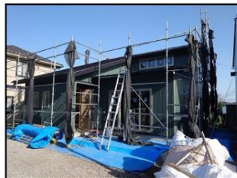
佐久市望月M様低新築工事もいよいよ大詰めとなりました。外壁のグリーン金属サイディング張りも終わり、太陽光発電パネルの設置工事、コーキング工事、屋根の雪止め金具と縦樋の設置工事が終われば足場の撤去。内部も塗装工事が終わって、『幻の漆喰』による左官工事の真っ最中。この後、タイル工事、内装工事から器具付けが終われば、クリーニングへと進みます。完了検査を受けて、ゴールデンウィーク中にはお引越しいった流れになる予定です。
