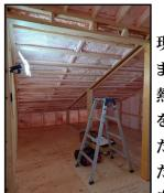
佐久市望月M様邸新築工事の 現場も順調に進んでいます。暮れ までに現場発泡ウレタンによる断 熱工事が完了。弊社ではA種1H を使うようになって、気密の取れ た冬に暖かい住宅をクリアしまし た。樹脂サッシの窓枠取り付け、 室内の天井のボード張り、床の合
