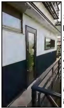
次は佐久市根岸のY様邸改修工事現場。軽井沢が夏の工事休止期間になり、ようやく左官工事の職人さんが入ってくれました。サッシを入れ替えた外壁は漆喰の塗り替えと腰の砂粒壁を黒で塗り直し補修。室内は既存京壁の表面を剥がして下地を補修、明るめの珪藻土で塗り替え、仕上げました。これで2階部分は工事が完了。1階部分も壁の下地やり替えは終わったので、塗装とクロス貼り、フロアの張り替えへと進めていく予定です。
