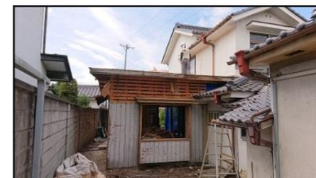
次は上田市大屋H様邸減築リフォーム工事から。昔、増築された東の平屋部分の解体撤去が完了しました。ここから外壁の補修、採光通風ドアの設置、軒天や屋根の補修へと工事を進めます。庭の防草対策や雨水対策にも知
