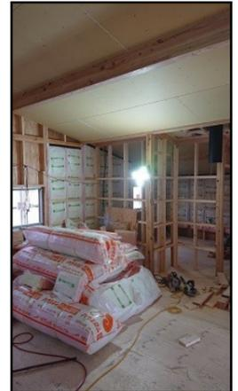
床板も搬入となったので木製建具の枠を加工して取り付けて、床張りへと現場は進んでいきます。
