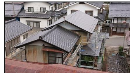
次はY様邸屋根葺き替え工事から。工事は概ね完了して、足場を撤去すれば完了の予定です。2階屋根と1階下屋が板金
