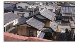
次はY様邸屋根葺き 替え工事から。旧中 山道に面した主屋の 瓦が老朽化。割れ や苔がひどくなり、 通行人に怪我をさせ
