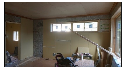
次は上田市武石沖M様邸改修工事。
