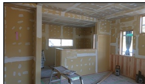
佐久市布施O様邸新築工事の現場から。
