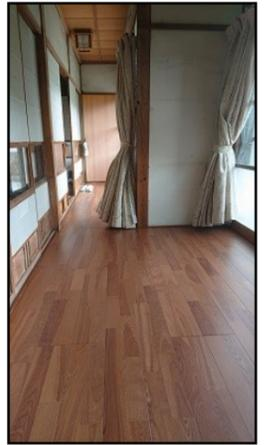
次は佐久市内山田様邸床張り替え工事から。柱をジャッキで持ち上げて、不陸をなるべく調整してから縁側の床を張り替えました。お施主様の了解のもと、既存床の上に下地をして重ねて張ったので、撤去して張り替えるよりも安価に出来ました。重ねた分、敷居との段差も解消されたのでつまづく危険も減りました。
