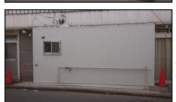
た。既存壁の撤去、 木下地補強、防水紙 張り、角波板張りで 工事完了。一部雨漏 りもしていましたが、 仕上げのコーキング で止めることが出来 ました。
