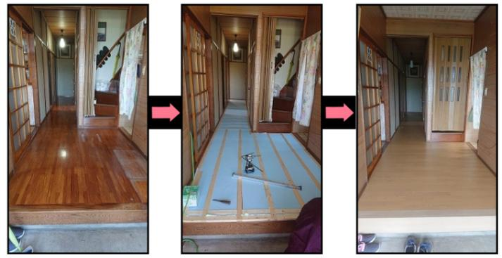
新築優先でお待たせしてしまったリフォーム工事を順次進めています。まずは佐久市前山O様邸玄関ホール床張替工事の現場から。『バリアフリー化して明るい床にしたい、断熱材も入れたい。』とのご要望。既存床は撤去せず、その上に下地と断熱材、仕上げに明るい色のフローリングとリフォーム框を施工しました。
