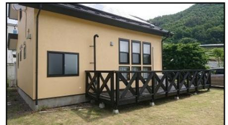
東御市和Y様邸ウッドデッキ修繕工事。木製の老朽化が進んだデッキ手摺りを撤去。床板も腐れが出ている箇所をキシラデコールで塗装しながら部材交換。所々にコーキングやルーフィングで補修がされていましたが余計に雨水が差し込んで
