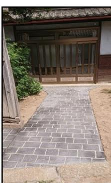
いのご要望。土間コンクリート打設時に型紙を敷いて、色砂を混ぜて表面をコテ処理する方法で石畳の模様をつけました。滑り止めの効果もあり、杖をつきながら介護者と並んで歩ける幅も確保しました。同時に庭に溜まる雨水の処理も柵を2箇所設置して対応しました。
