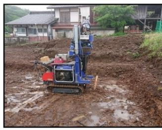
礫混じりの安定地盤で地盤改良は不要との判定結果が出ました。ベタ基礎で施工が可能で一安心です。計測機械もさることながら、メモ書きする紙もペンも濡れても大丈夫なものとのこと。雨天でも調査できるわけですね。基礎工事の掘削やコンクリート
