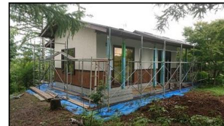
次は上田市腰越T様住宅新築工事の現場から。躯体の防腐処理、樹脂サッシの取付が終わり、基礎と浴室壁の吹付断熱が完了しました。現場発泡ウレタンも色んな種類がありますが、迷わず一番グレードの高い物を採用しています。寒冷地での施工も考慮して、この材料に決めました。水廻り機器の最終決定を待って床下の配管工事、他の工事へと工事は進んでいきます。
