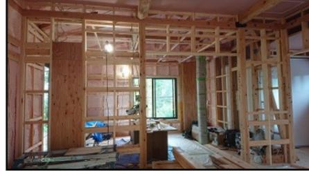
内部はユニットバスの設置が終わり製作建具のための木枠の加工や取付和室の造作へと進んでいきます。
