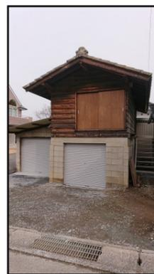
次は佐久市田口S様物置改修工事から。開口部をシャッターと木製建具で塞ぎ、2階に上るアルミ階段を設置しました。農機具や道具、タイヤ等々、多目的に収納できるように、階段が付いたことで、2階もこれまで以上に使えます。古い建物も使い方で変わります。利用度を上げるリフォームの成功例だと思います。
