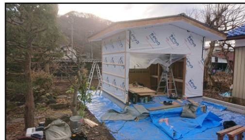
佐久市内山H様物置新築工事。建方が終わり、外壁の下地工事を施工中です。
