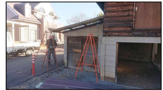
佐久市田口S様物置改修工事。屋根の葺替え、シャッター取付、アルミ階段設置等々、古い物
