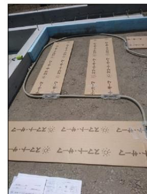
気式の床暖房を設置しました。基礎のコンクリートに蓄熱させて床下を暖める方式
